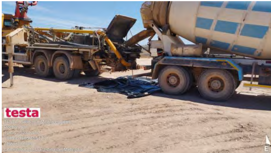
Descarga de hormigón correcta
