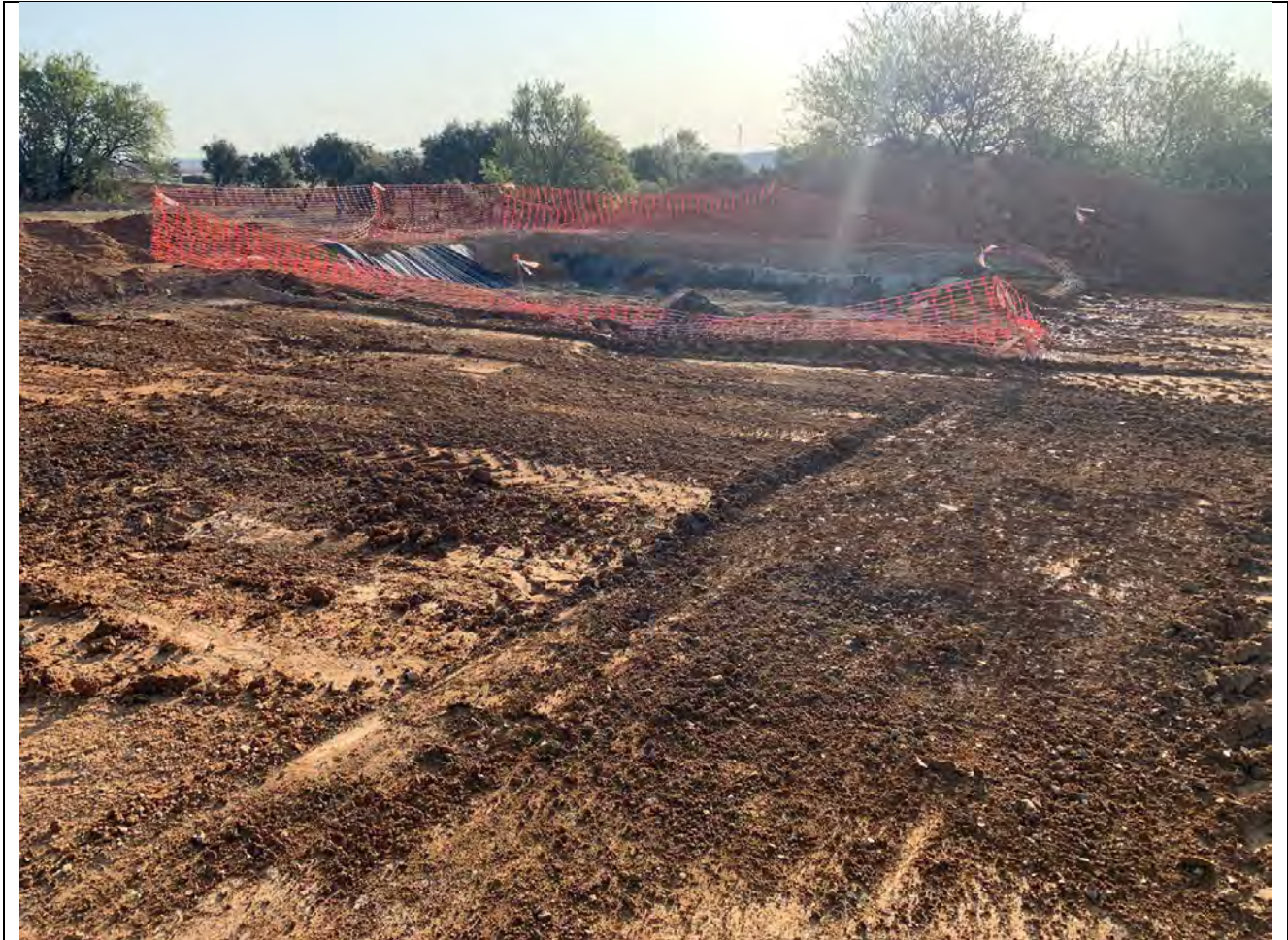
Imagen 1. Suelo limpio de residuo de hormigón
