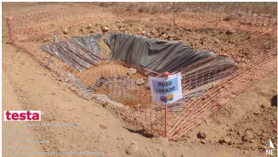
Nuevo pozo de lavado bien acondicionado
