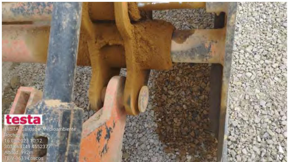
Derrame en punto limpio
