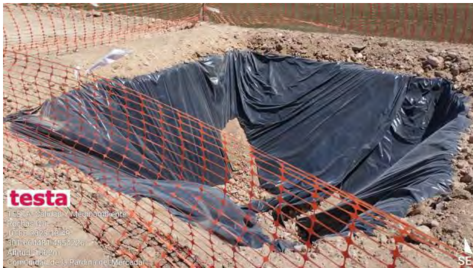
Nuevos pozos en avance de obra correctos
